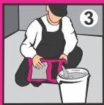
**3** Для подготовки раствора залейте водопроводную воду комнатной температуры в чистую ёмкость из расчёта 15,5-17,5 л воды на 1 мешок (30 кг).
